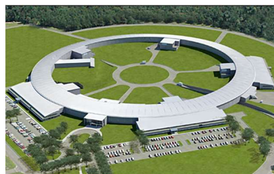
NSLS-II - Estados Unidos Início das operações: 2014 Energia: 3 GeV
