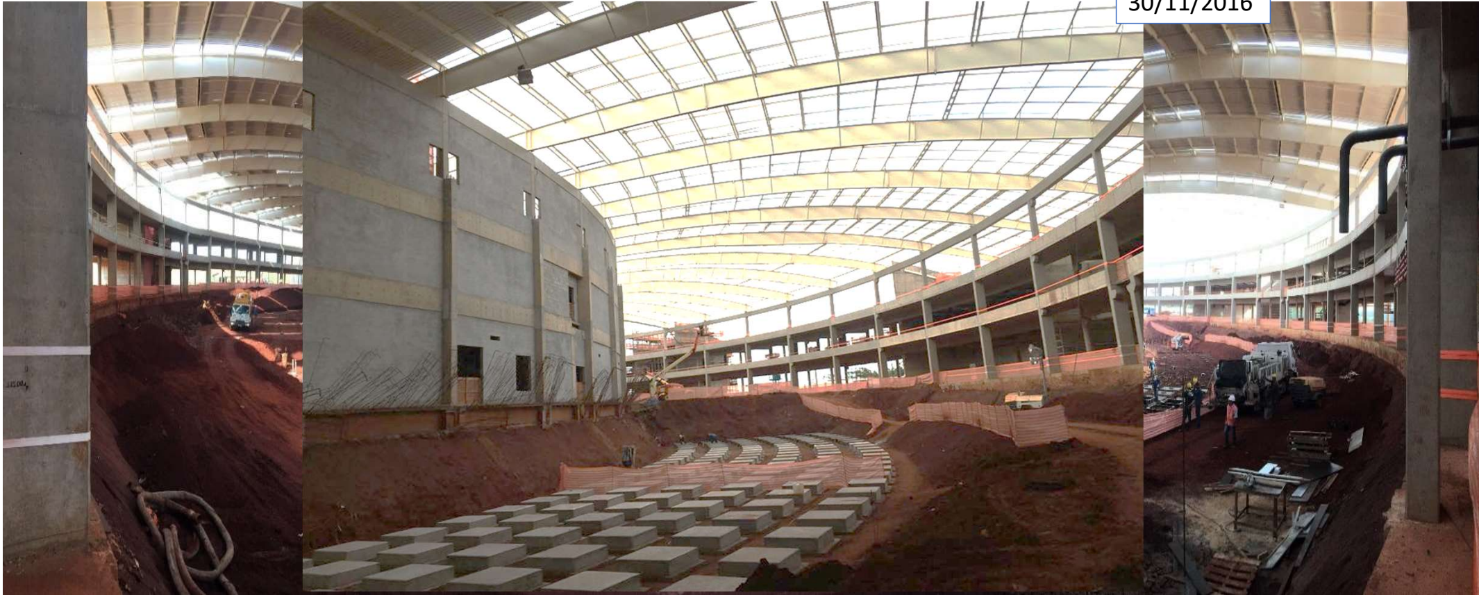
Croncretagem dos pilares de estabilidade do piso dos aceleradores do Sirius
